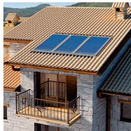
Пример встроенного монтажа (только Kairos XP 2.5 V)
