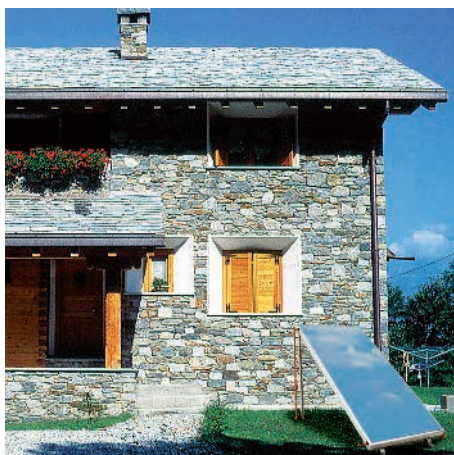
Пример наземного монтажа
